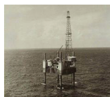
Plataforma elevatória P-1, primeira plataforma móvel de perfuração da Petrobras construída nos anos de 1967 e 1968
